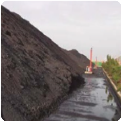
Aspersión con tuberías fijas
