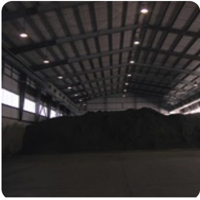
Sistema de Acopio y despacho de concentrados desembarcados - Puerto de Antofagasta, II Región.
