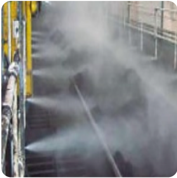
Figura 2.15 Ej. BP Descarga de vagones con nebulización de agua
