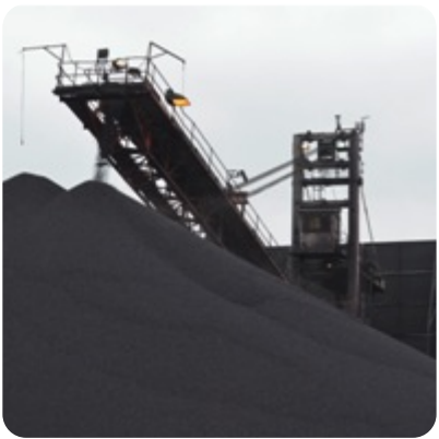
Formación de acopios con apiladores longitudinales, Huasco
