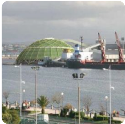
Domo Proyecto FENOSA almacenamiento Carbón año 2003, La Coruña, España.
