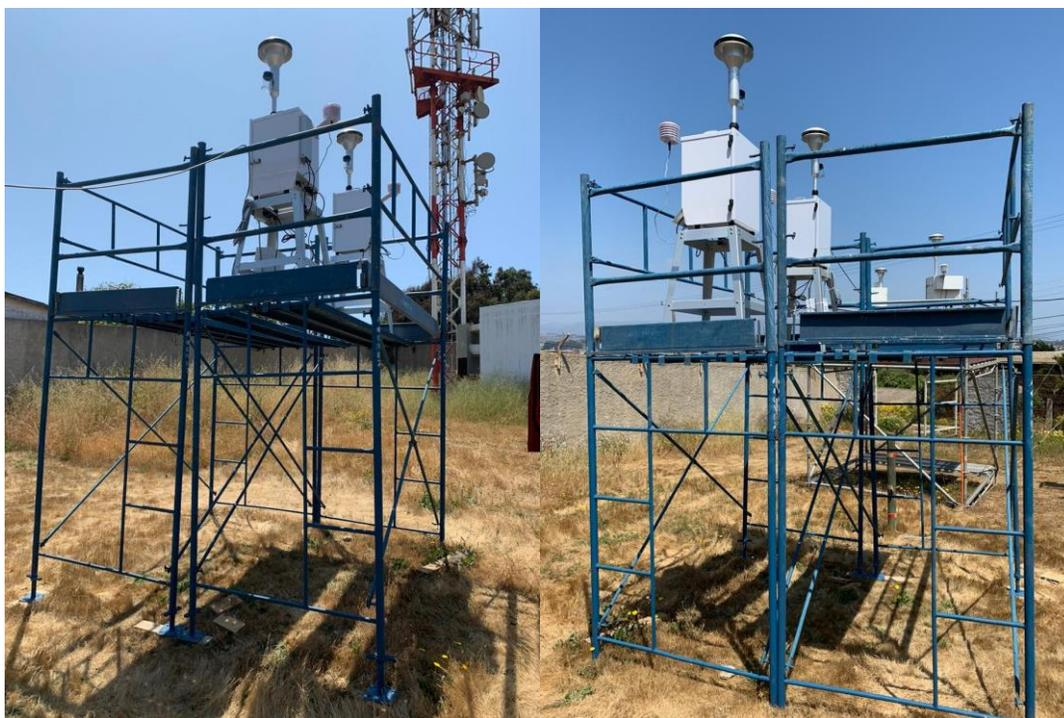
Figura 1. Instalación de infraestructura de montaje para los muestreadores de referencia en la estación Quintero.
