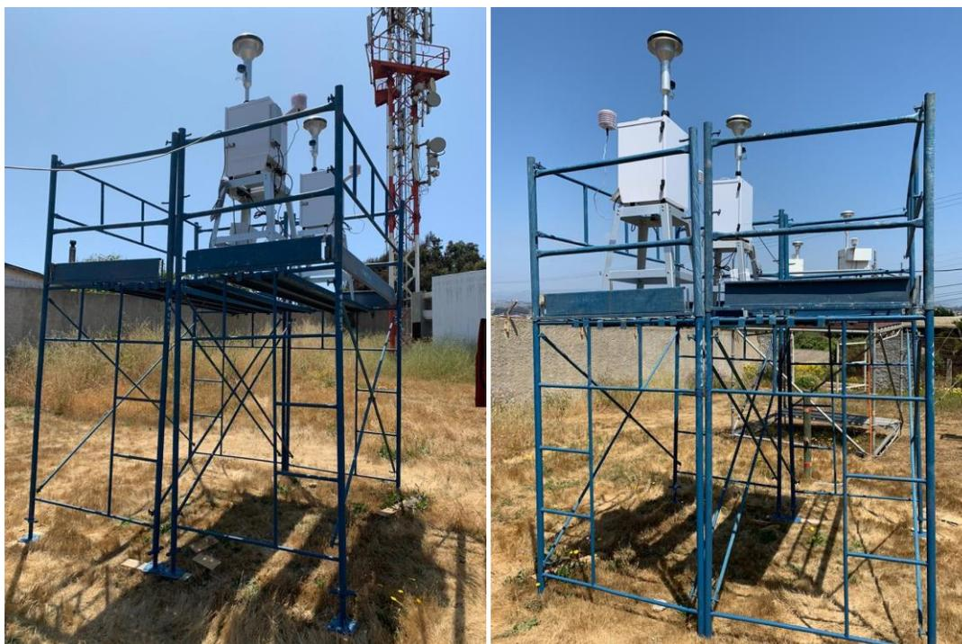
Figura 8. Instalación de infraestructura de montaje para los muestreadores de referencia.
