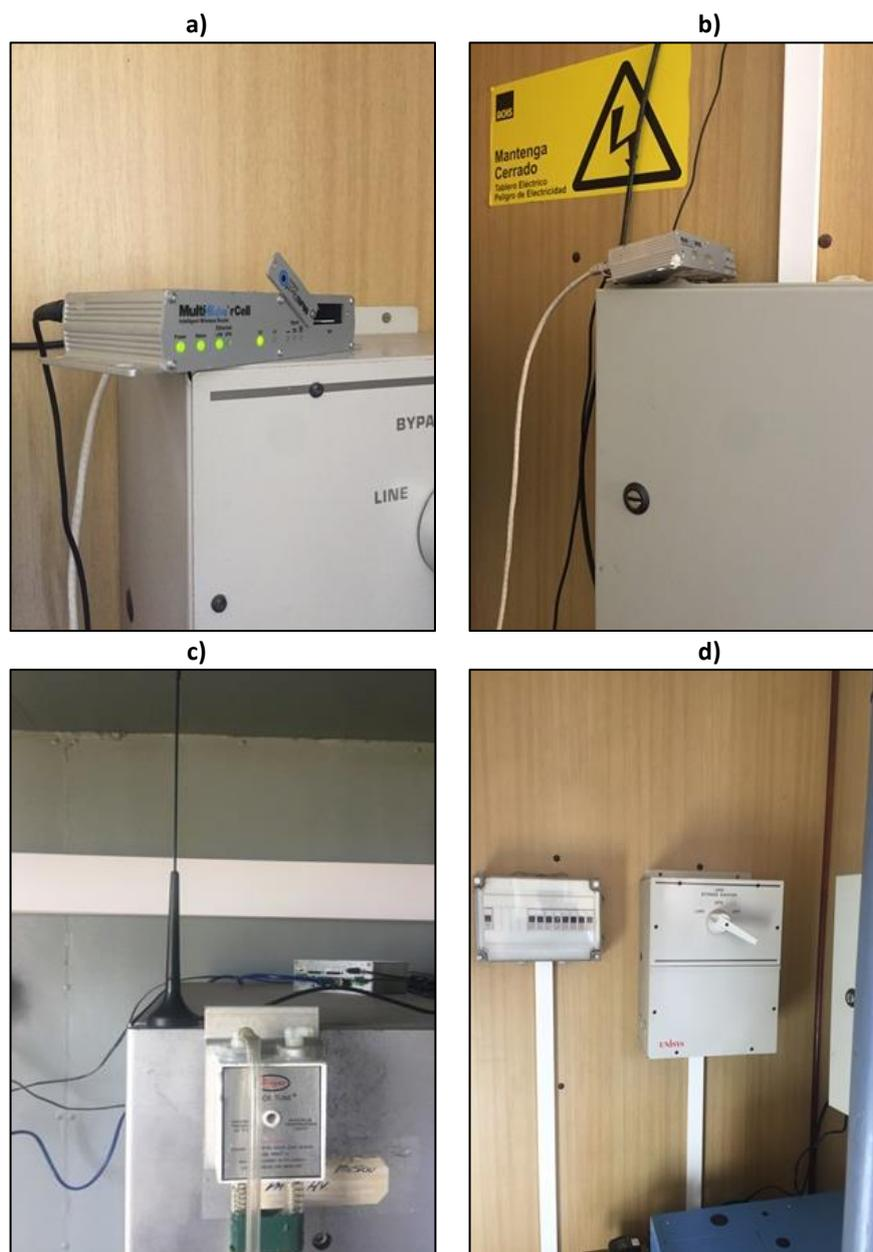
**Sistemas de comunicación e instalación eléctrica:** Se observa que los dispositivos de comunicación como Router-GPRS o Modem no tienen un lugar específico en la estación. Respecto a las instalaciones eléctricas se observa que existen tableros con diferenciales y conexión a sistemas de respaldo del tipo Uninterrumpible Power Supply (UPS), según los requerimientos de cada estación.
