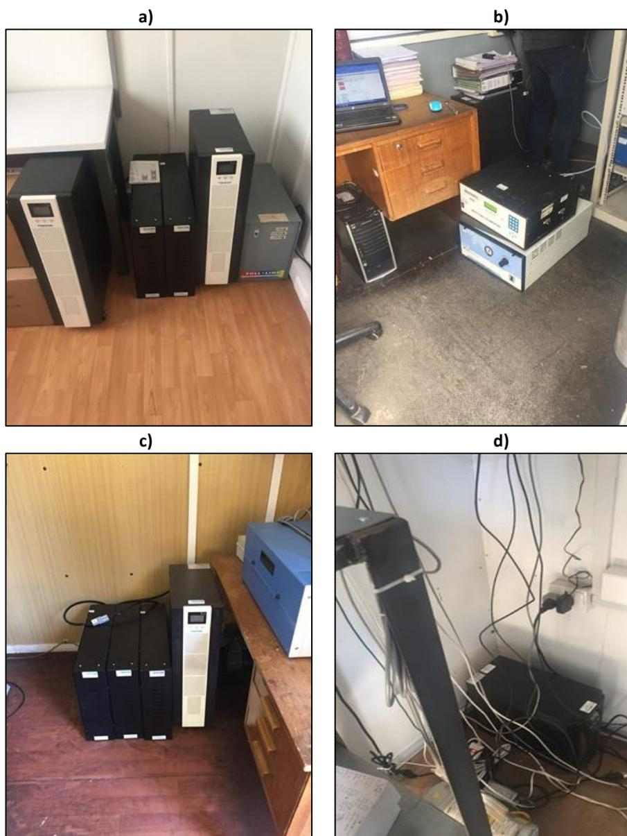
**Instalación de UPS:** Se observa que todas las estaciones tienen sistemas de respaldo del tipo Uninterrumplible Power Supply (UPS). Se recomienda mejorar las instalaciones de equipos complementarios, evitando el exceso de cables en general sin una adecuada identificación.
