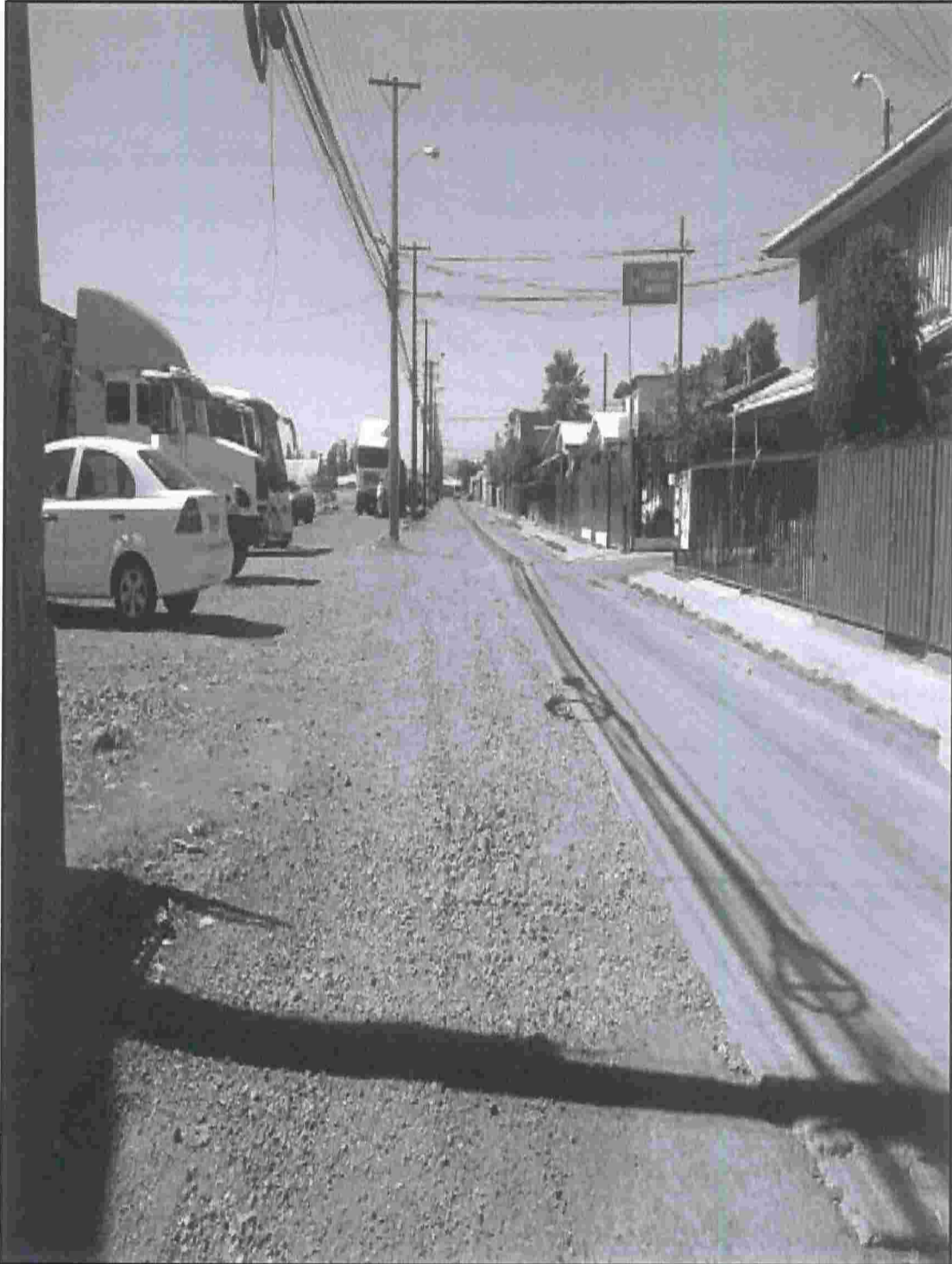
Figura 2: Estado actual del camino a pavimentar.
