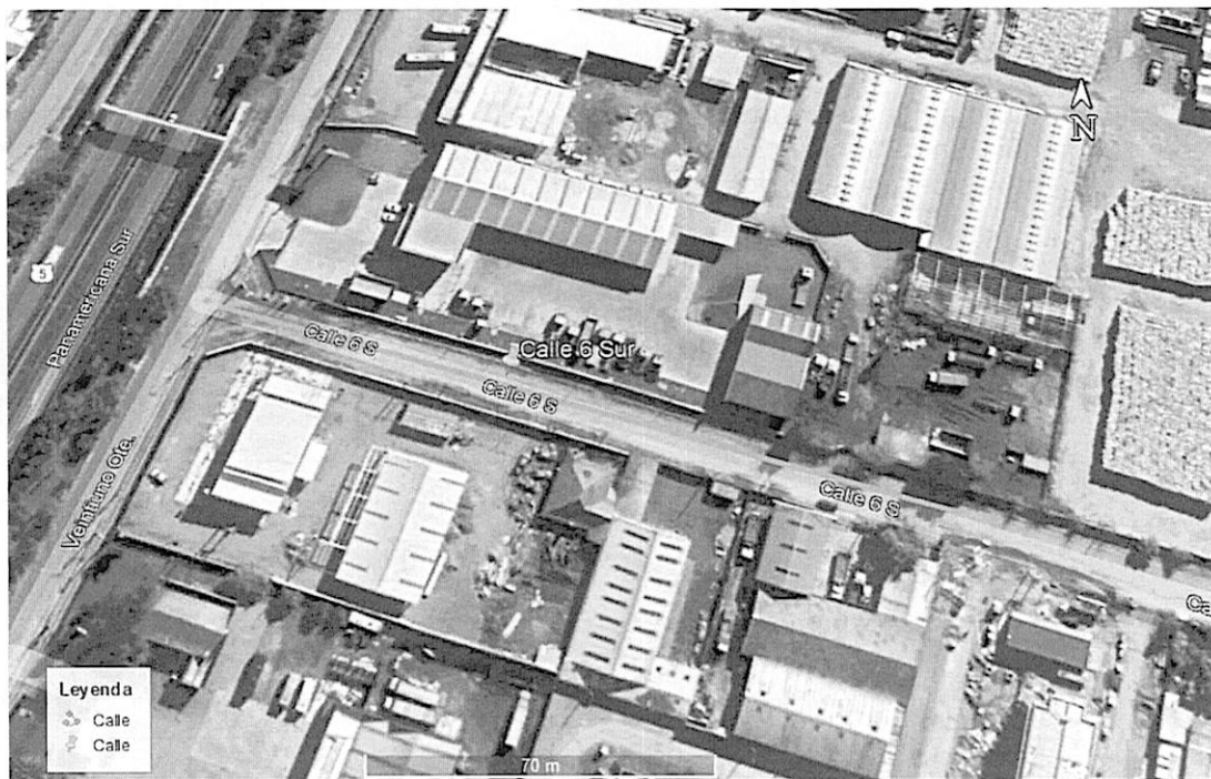
FIGURA 7: TRAMO NO PAVIMENTADO DE LA CALLE 6 SUR
